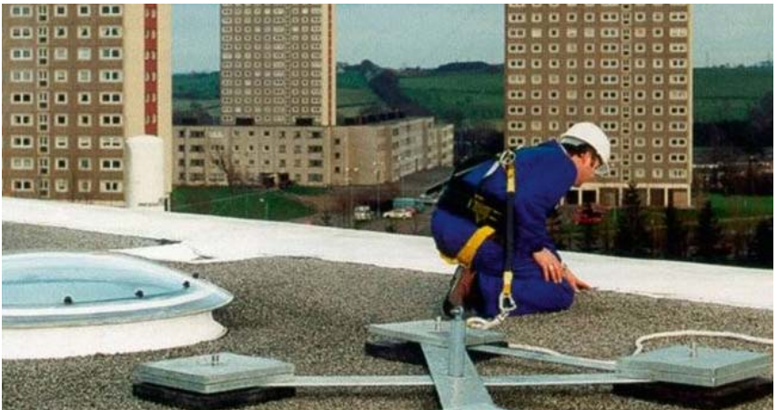
Bild 32: Durch Eigengewicht gehaltene Anschlageinrichtung (z.B. Betongewichte)
