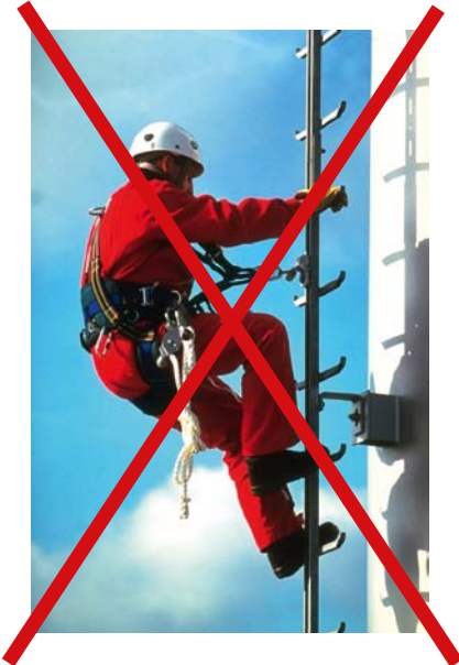
Bild 35: Unzulässige Verlängerung des Abstandes Körper zum Auffanggerät durch zu locker angelegten Gurt
